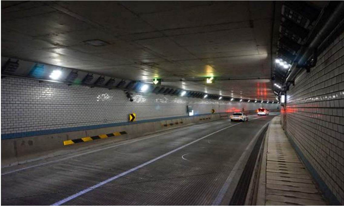
BOX구간 내부 전경
