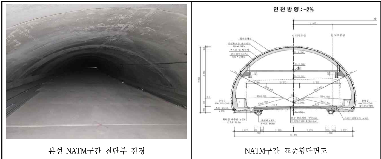
【사진 3.3.5】 NATM구간 천단부 전경
