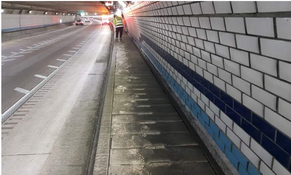
NATM구간 공동구 전경
