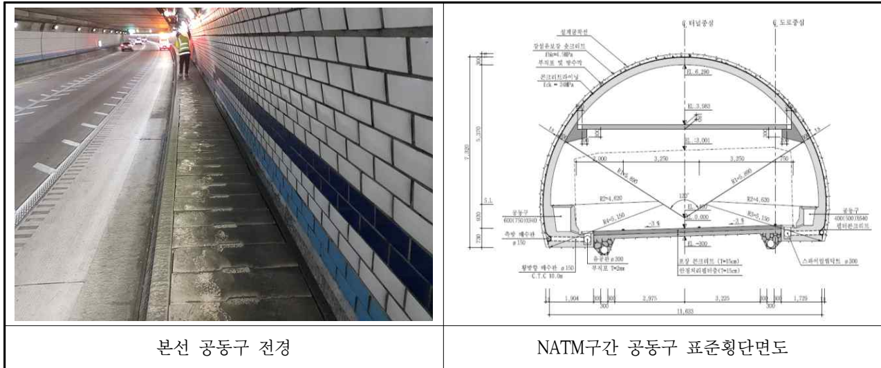
【사진 3.3.13】 공동구 전경
