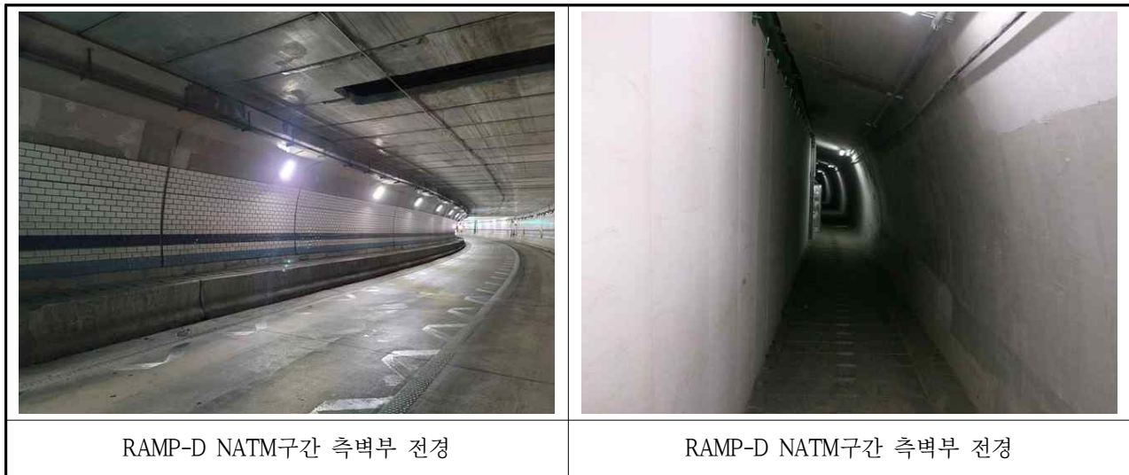
【사진 3.3.25】 NATM구간 측벽부 전경
