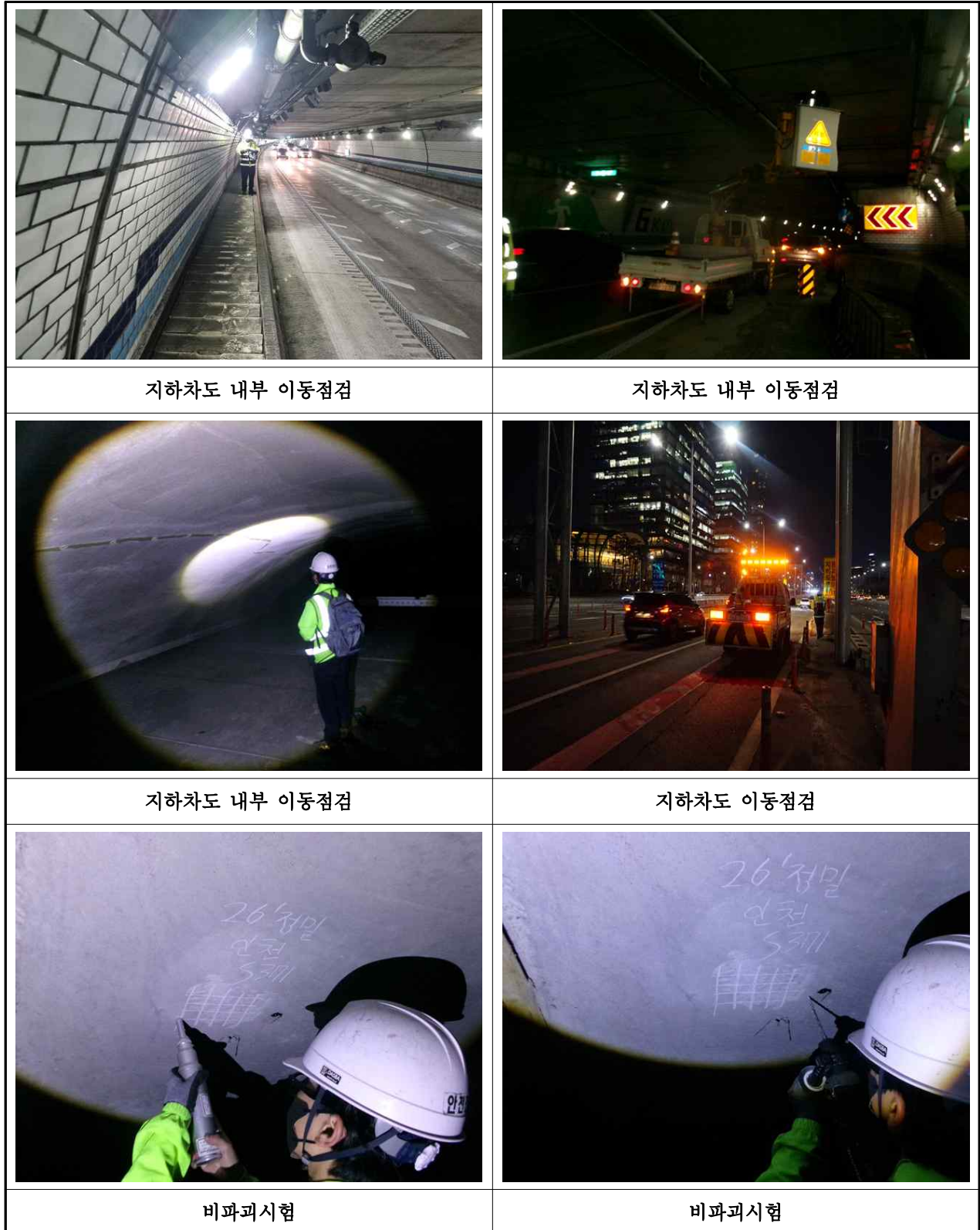
【사진 3.1.1】외관조사 전경
