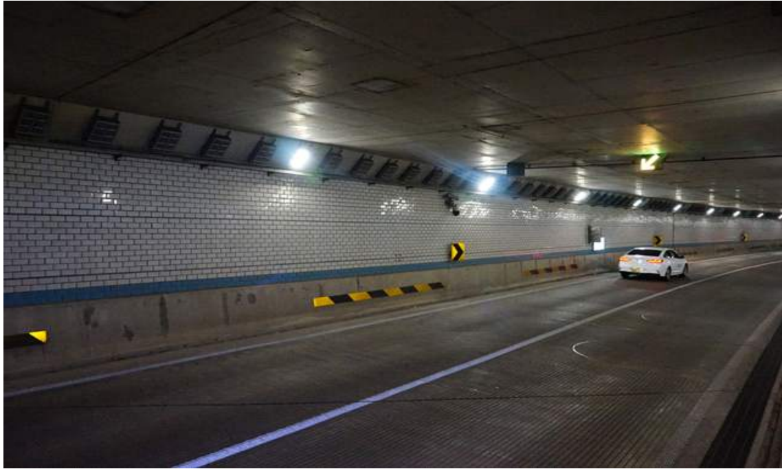
BOX구간 벽체 전경
