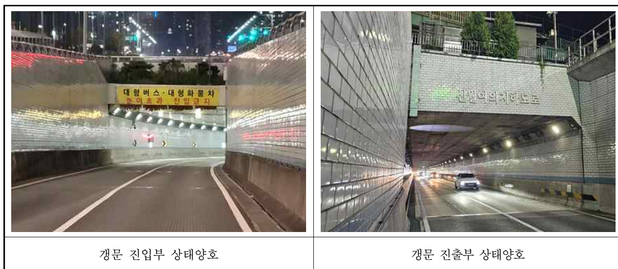
【사진 3.3.18】갯문 손상현황
