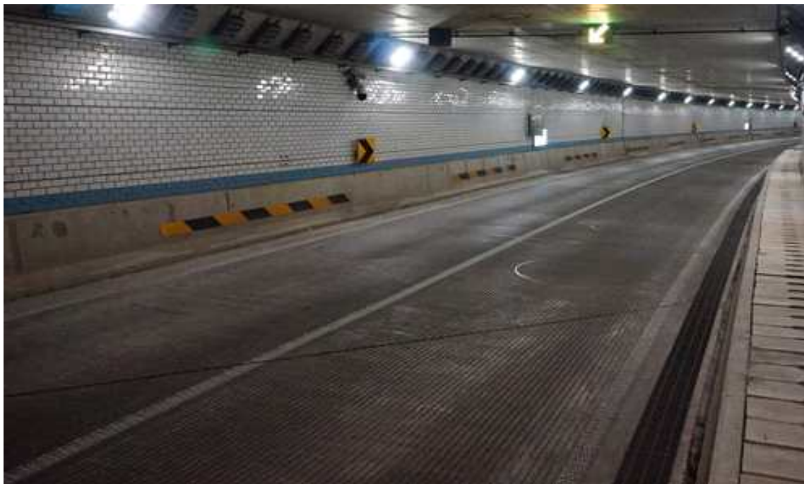
BOX구간 포장 전경
