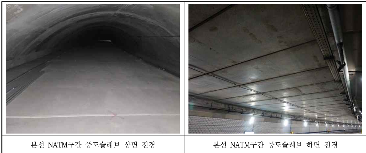
【사진 3.3.9】 NATM구간 풍도슬래브 전경
