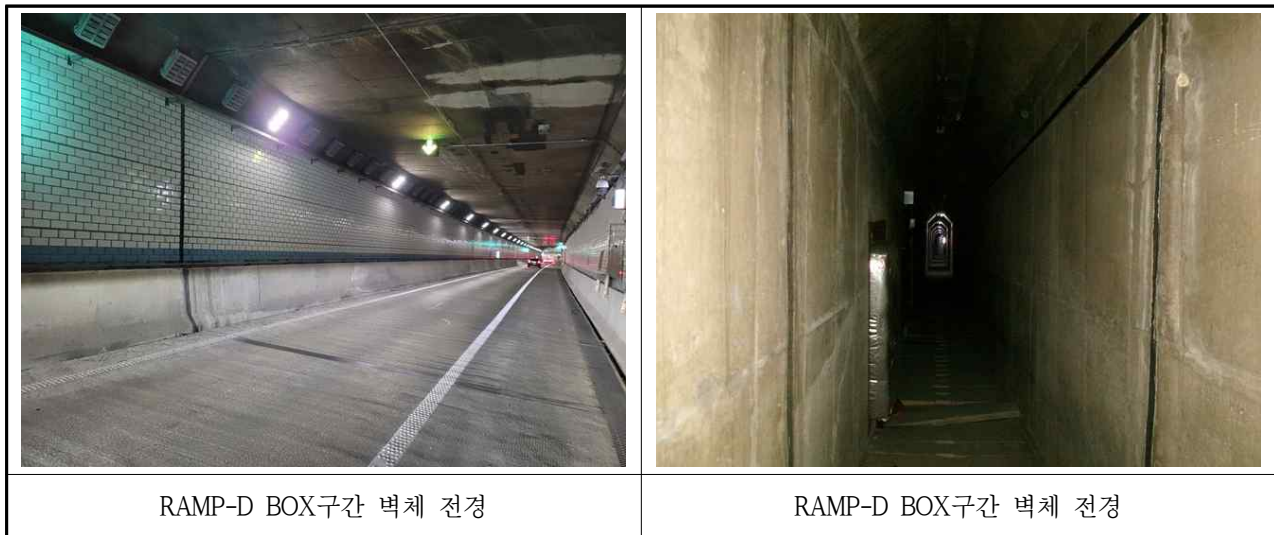
【사진 3.3.21】 BOX구간 벽체 전경
